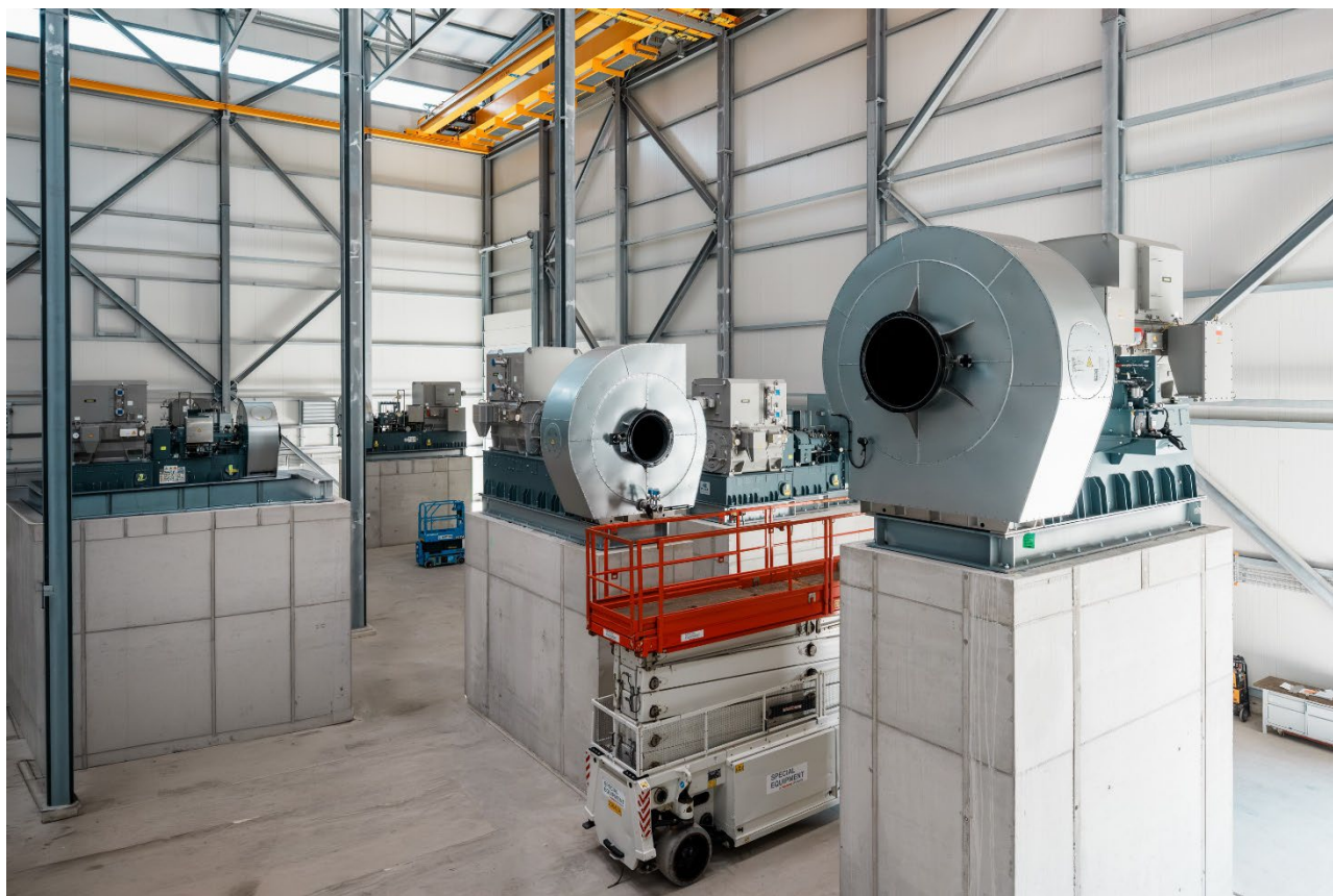
Фото: Первые компрессоры PILLER успешно поставлены: с установкой машин на предусмотренные бетонные основания достигнут очередной важный этап в реализации крупного проекта BASF.
