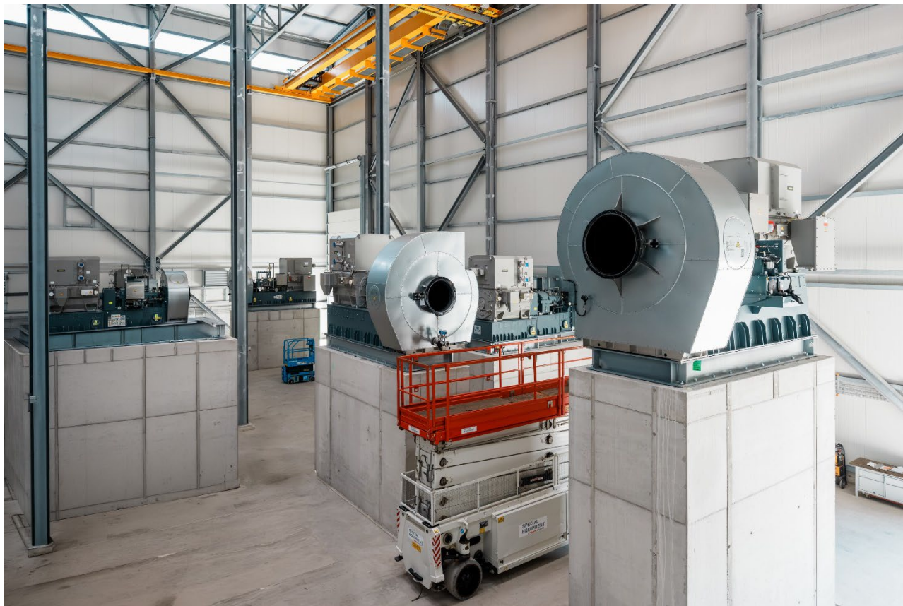
Título de la imagen: Los primeros compactadores PILLER se han colocado con éxito: con la colocación de las máquinas sobre los zócalos de hormigón previstos, se ha alcanzado otro hito fundamental en el gran proyecto de BASF.
