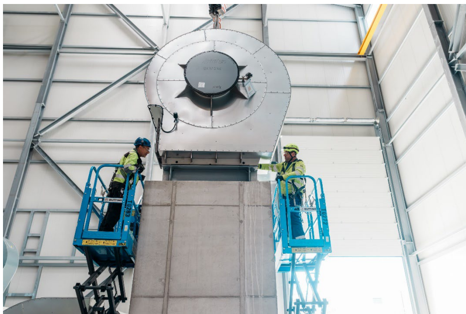
Título de la imagen: Instalación preliminar y fijación de las máquinas en BASF.
