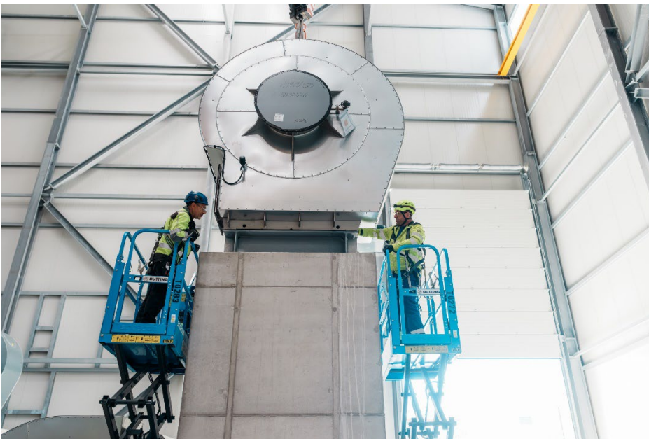
Bild-Titel: Vorbereitende Installation und Befestigung der Maschinen bei BASF.
