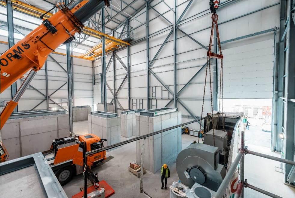
Bild-Titel: Maschinenaufstellung auf die vorbereiteten Betonblöcke.
