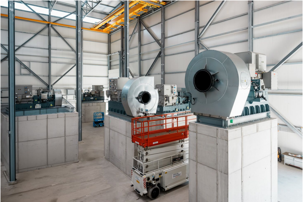
Bild-Titel: Die ersten PILLER-Verdichter sind erfolgreich positioniert: Mit dem Absetzen der Maschinen auf den vorgesehenen Betonsockeln ist ein weiterer zentraler Meilenstein im BASF-Großprojekt erreicht.
