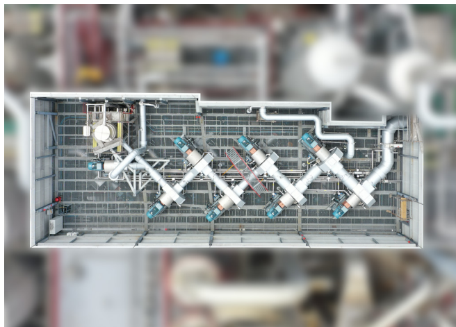
Tecnologia de Bomba de Calor por Compressão de Vapor: Compressão de vapor com conexão em série de oito VapoFlex®.
