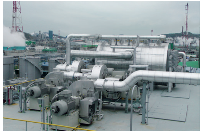
Abb. 4: Der PILLER Verdampfer mit vierstufigem Gebläse-System zur Dampfbereitstellung
