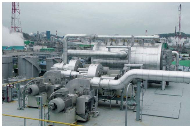
Рис. 4. Испаритель PILLER с 4-х ступенчатой системой вентиляторов для производства пара
